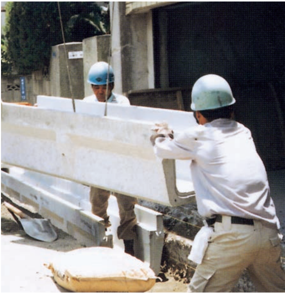
▲内吊りにて施工
