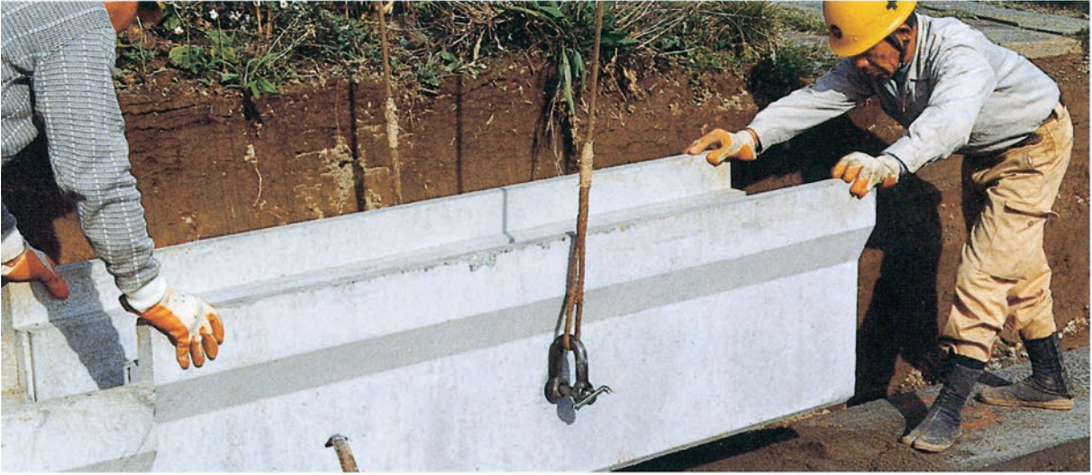
▲道路用鉄筋コンクリート側溝の施工状況
