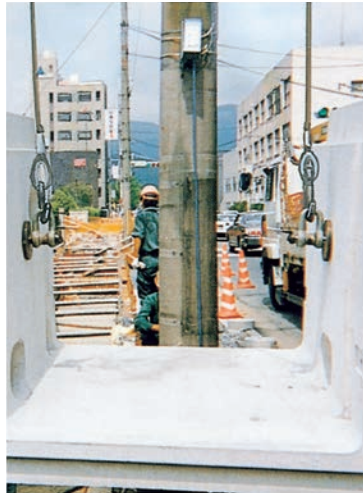
▲共同溝の反転テスト及び施工状況
