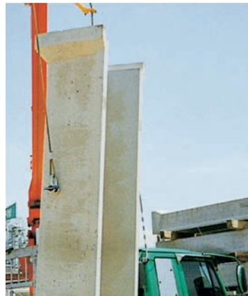
▲ベンチフレーム反転後トラック積込状況
