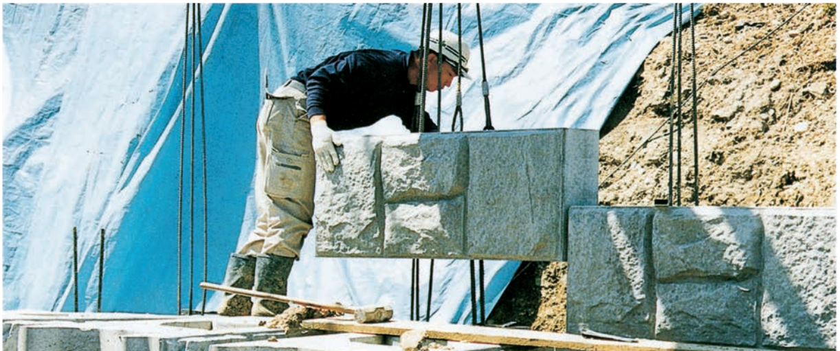
▲大型ブロックの施工状況
