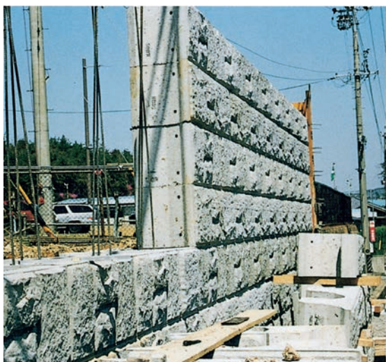
▲大型ブロックの施工状況
