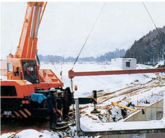
▲大型フリュームの反転テスト及び施工状況
